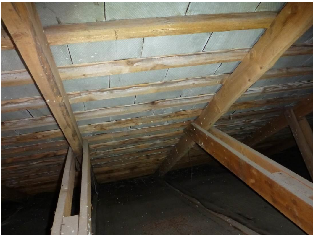
Foto 4 Lægterne i tagrummet fremstår generelt med lidt tørre fugtskjolder.
