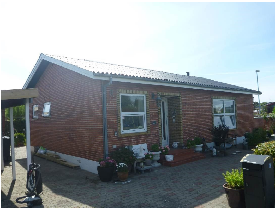
Foto 1 Oversigtsbillede set fra nordvest – bryggerset er ved det bageste vindue i gavlen.
