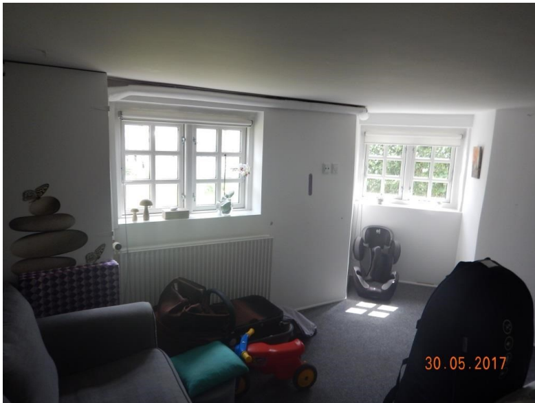
Pladebeklædt væg i kælderværelse.
