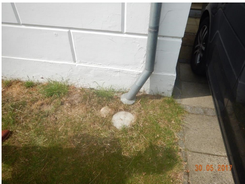
Ny tagedløbsbrønd på nordøstligste hjørne.
