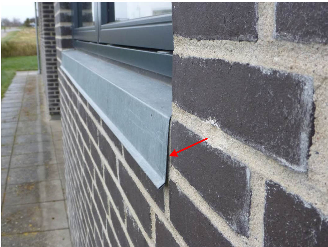
Foto 10 Zinksålbænkene er generelt udført uden fremspring, men har dog en mindre drypkant.
