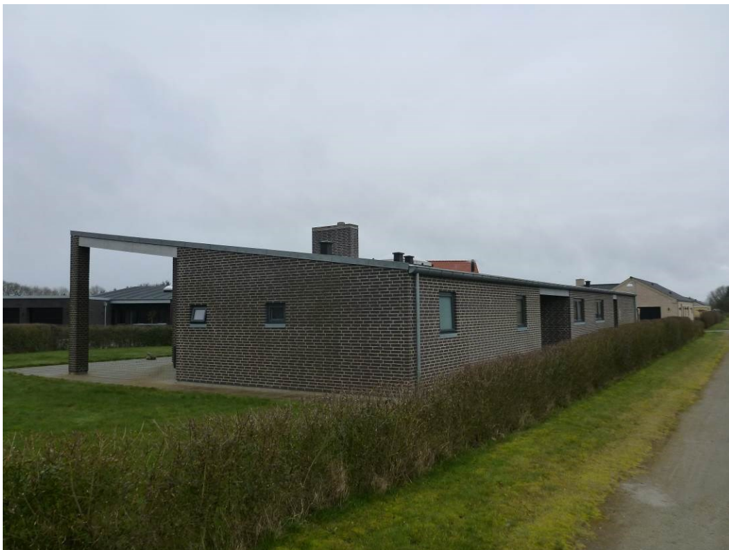
Foto 3 Oversigtsbillede set fra nordøst – bemærk den murede søjle yderst til venstre.
