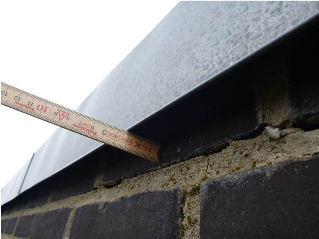
Foto 9 Zinkinddækninger langs murkroner, er udført med et godt fremspring, på ca. 3 cm.
