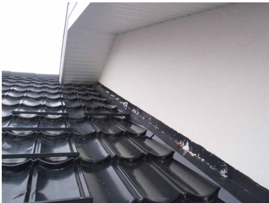
Foto 9 visende tidligere gavlle blændet udvendigt fra
