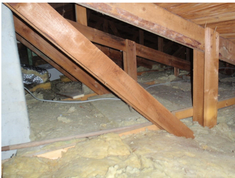
Foto 6 visende gitterspær – ikke tilgængelig
