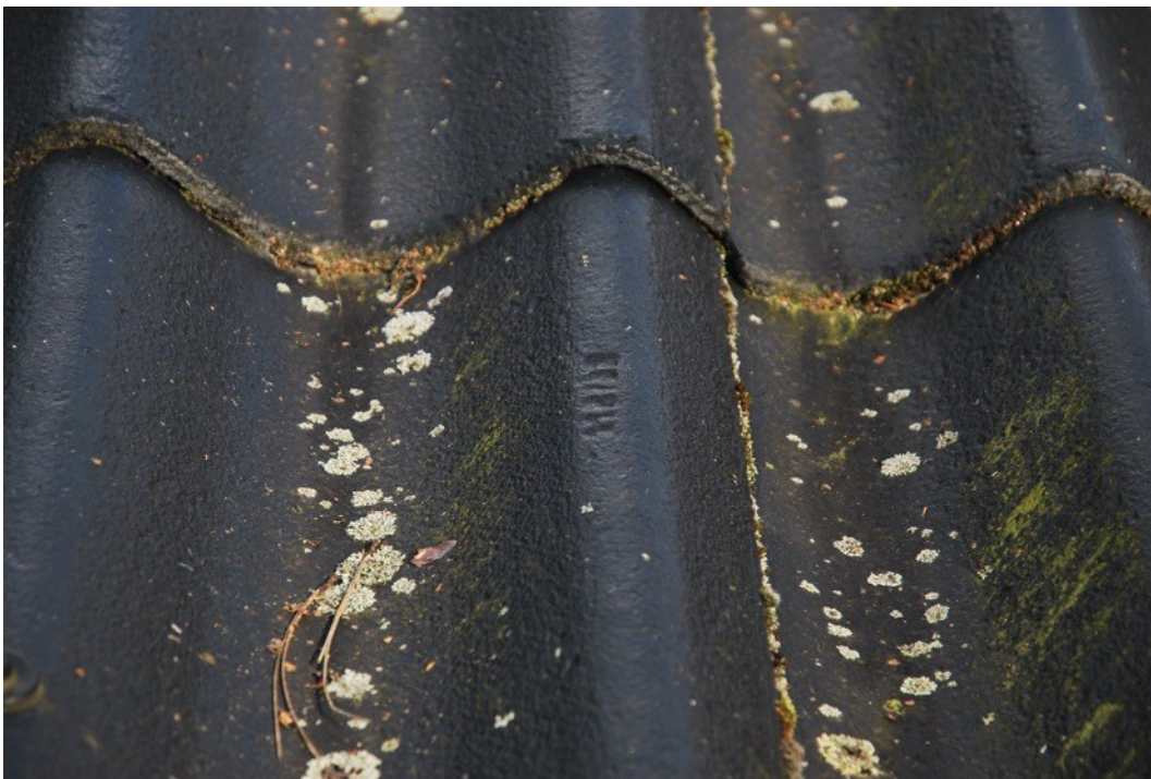
Foto nr. 2 Taget er dækket med de originale tagplader fra 1973. Pladerne er afrensede og malede, skønsmæssigt for 5-8 år siden
