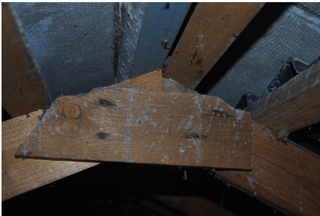
Foto nr. 5 Indtørret slam på spær og taglægter under rygningen i den inderste del af tagrummet
