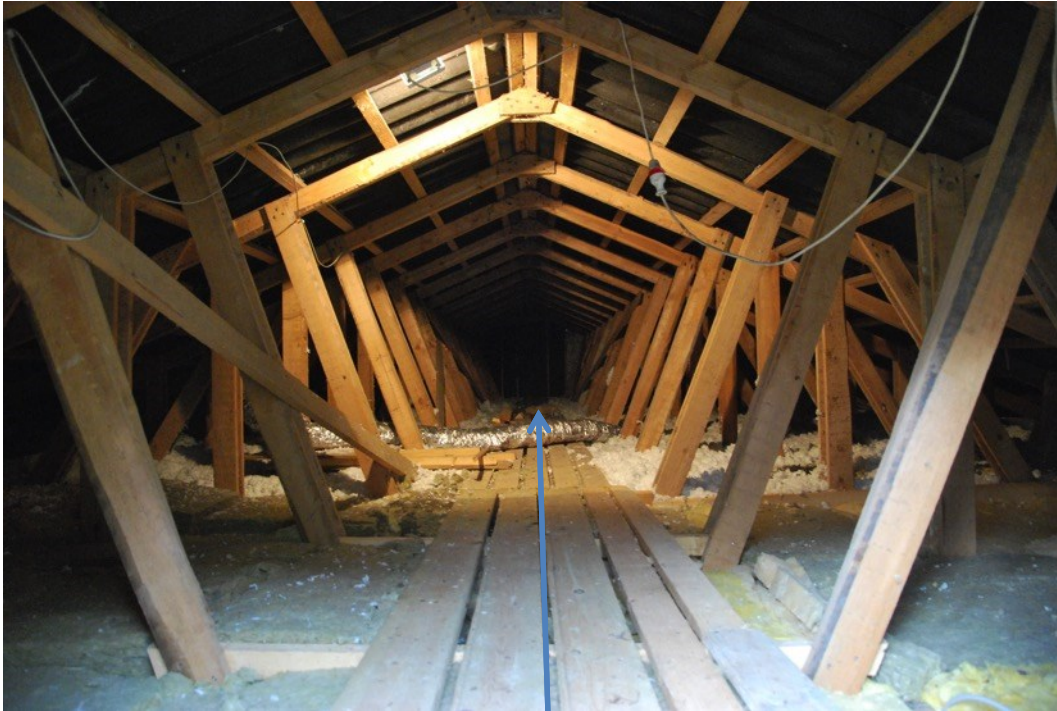
Foto nr. 3 Tagrummet set fra lemmen i sydgavlen. Lav konstruktionshøjde, gitterspær og indblæst mineraluld i 4/5-dele af tagrummet
