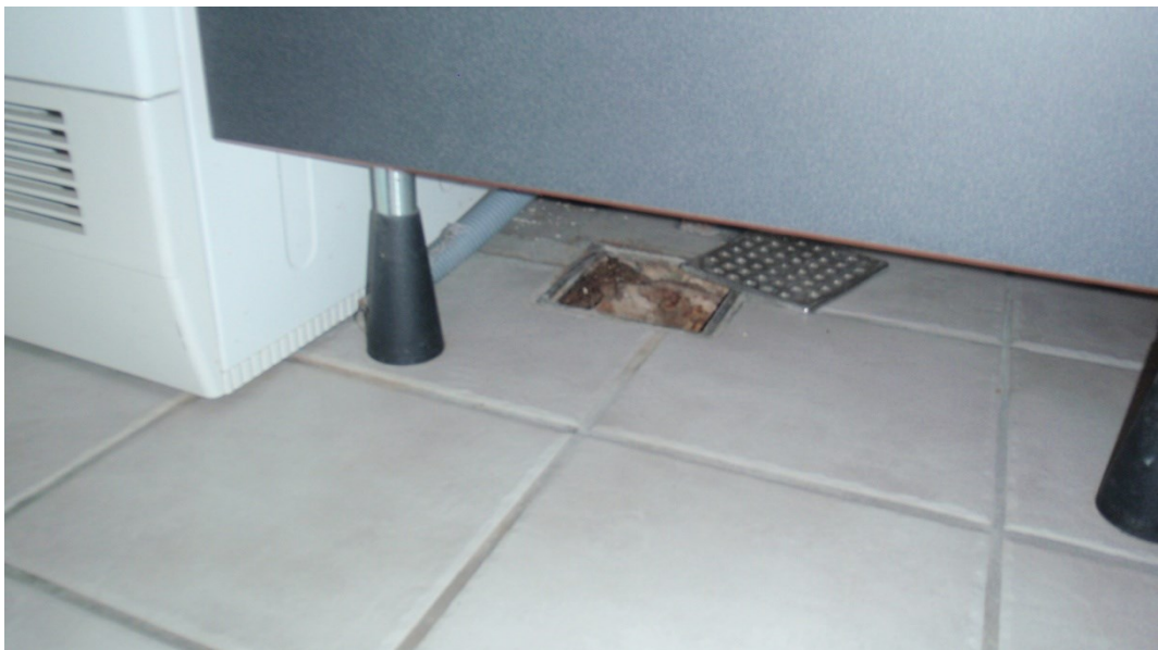
Foto 8 visende bryggers gulvafløb under skab
