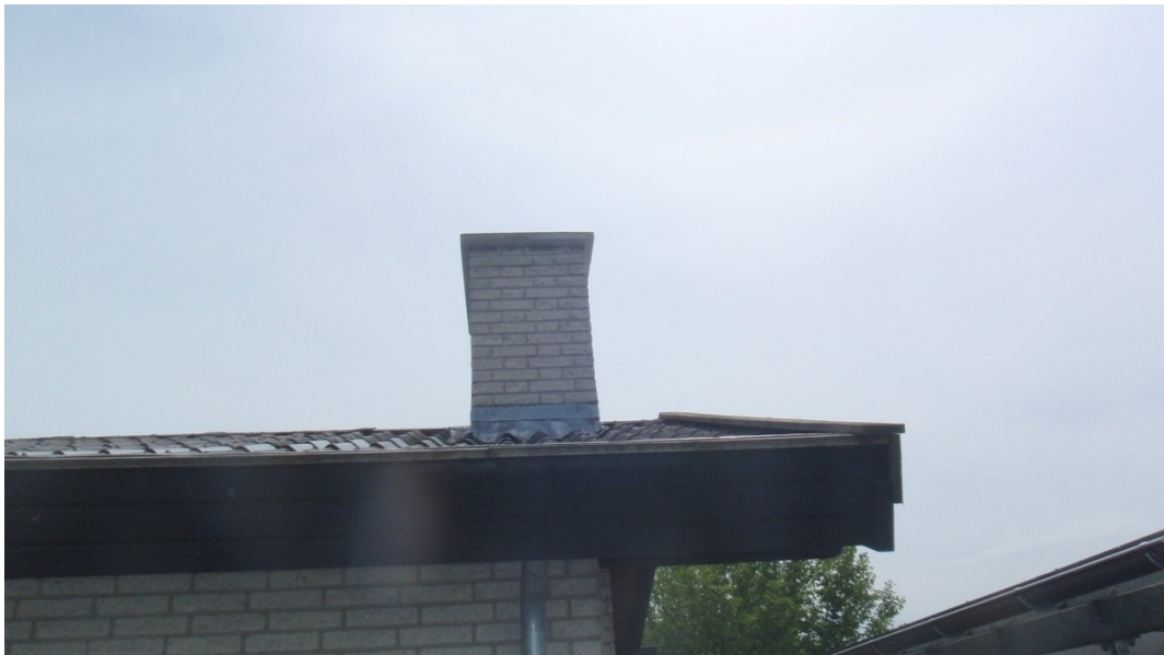
Foto 7 visende skorsten udbedret – Ommuret
