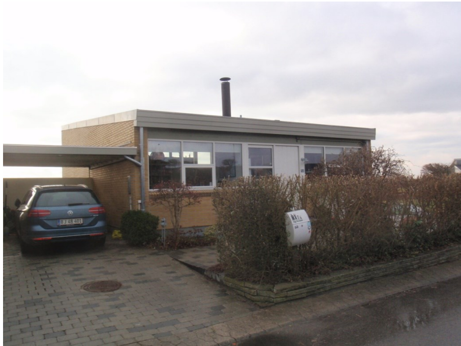
Foto 1 visende huset set fra øst
