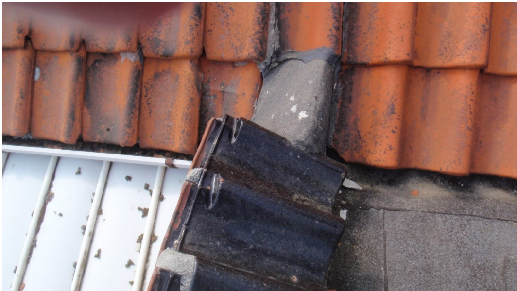
Foto 6 visende 2 rækker tagsten leder vand ind til naboen
