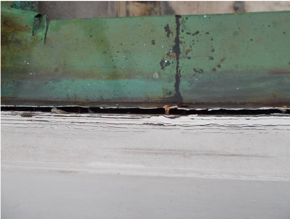
Utæthed mellem kobberplade og underkarmtræ.
