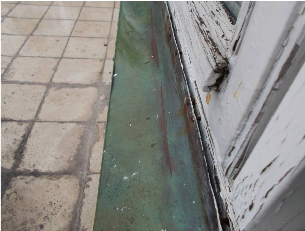
Utæthed mellem kobberplade og underkarmtræ.
