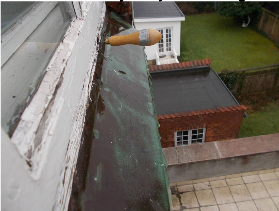
Blødt underkarmtræ og defekt vindueskit.
