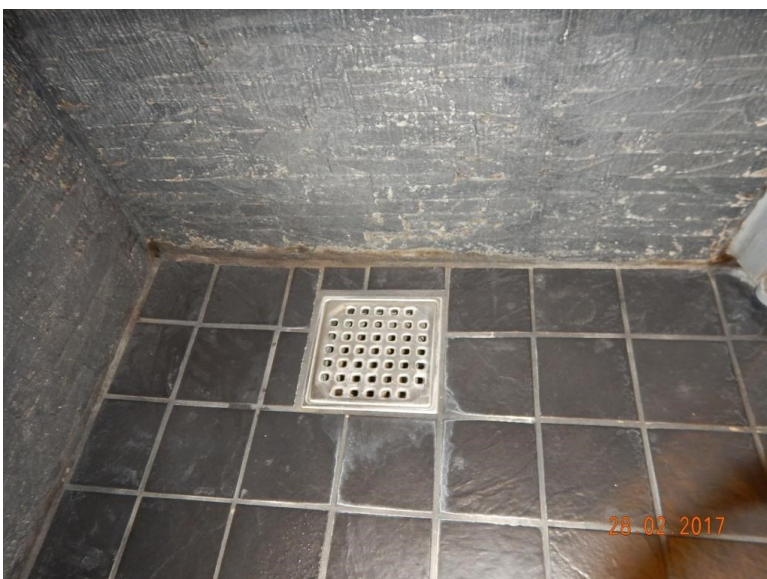
Gulv afløb i bruseniche i stort badeværelse.
