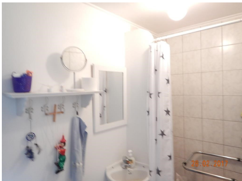
Skillevæg mellem bagindgang/ bryggers og badeværelse, som er udført som let skillevæg, set fra det lille badeværelse.
