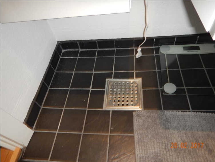
Gulv afløb i stort badeværelse til venstre for badeværelsesdør.
