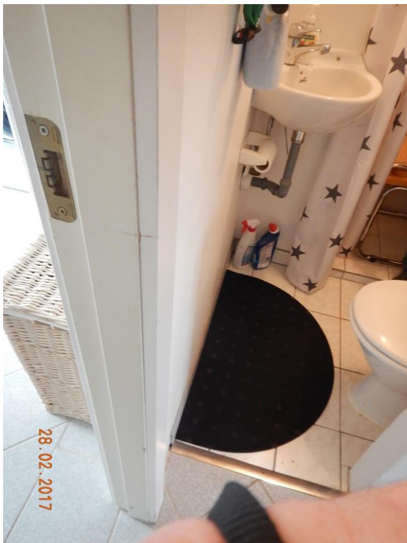
Skillevæg mellem bagindgang/ bryggers og badeværelse, som er udført som let skillevæg set fra dørkarm.
