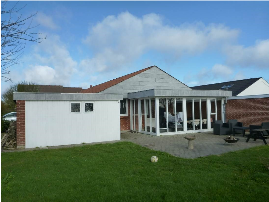
Foto 3 Oversigtsbillede set fra sydøst – bemærk udestuen opbygget ved boligens gavl.
