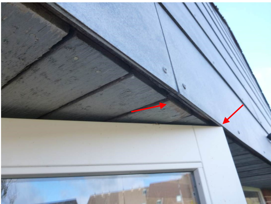
Foto 7 Terrassedøren mod vest er tæt på udhænget – bemærk slidmærkerne på underbeklædningen.
