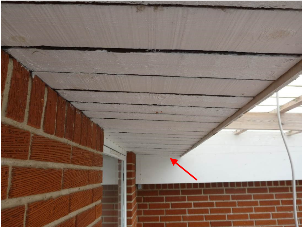
Foto 9 Pladeinddækning mod nord, ved overgang mellem udestue og boligens udhæng, ses at være tilpasset skævheden.
