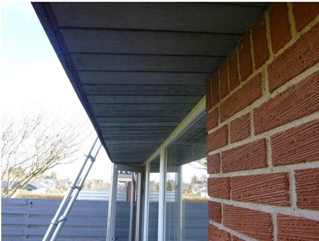
Foto 5 Underbeklædningen ved vestgavlen, ses tydeligt at være skæv, og meget tæt på døren, når denne åbnes.
