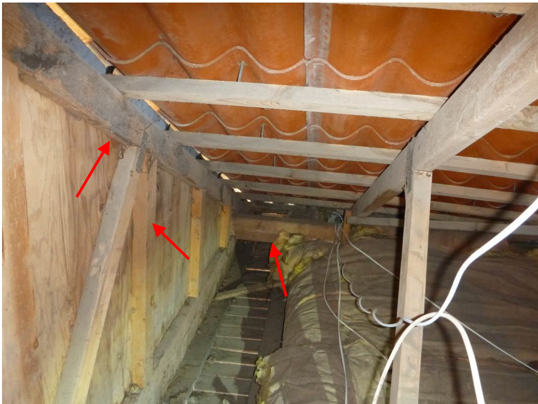
Foto 4 Gavlen mod vest, set fra tagrummet – bemærk gavlsparret, de lodrette stolper, og remmen ved tagfoden.
