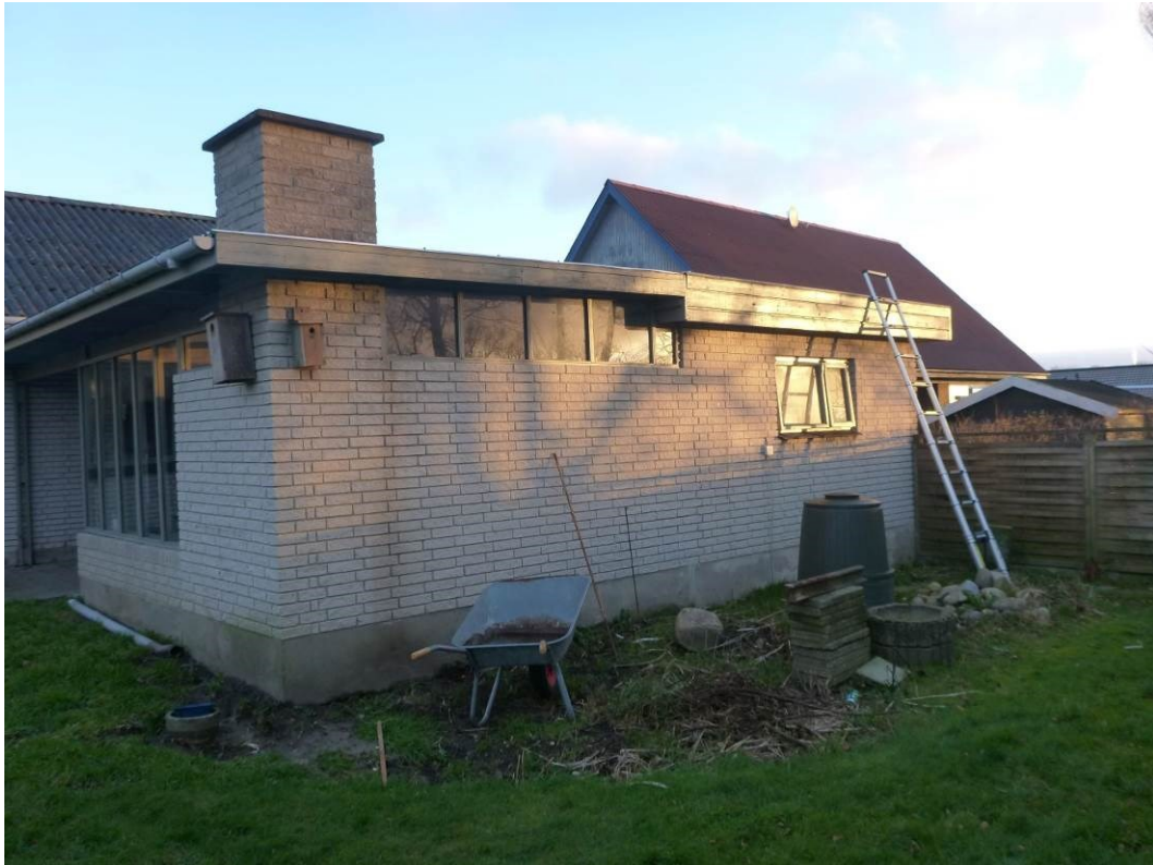
Foto 7 Ved sydfacaden kan der opstilles en stige for besigtigelse, bemærk dog terrænet, der indikerer en tidligere bygning.
