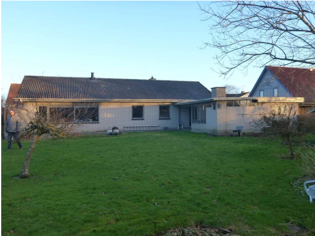
Foto 3 Oversigtsbillede set fra sydvest – den overdækkede terrasse og garagen ses til højre
