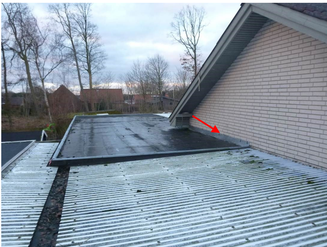
Foto 5 Garagens tag set fra stige, opstillet ved carporten – bemærk inddækningen langs husgavlen, der kan være svær at se.
