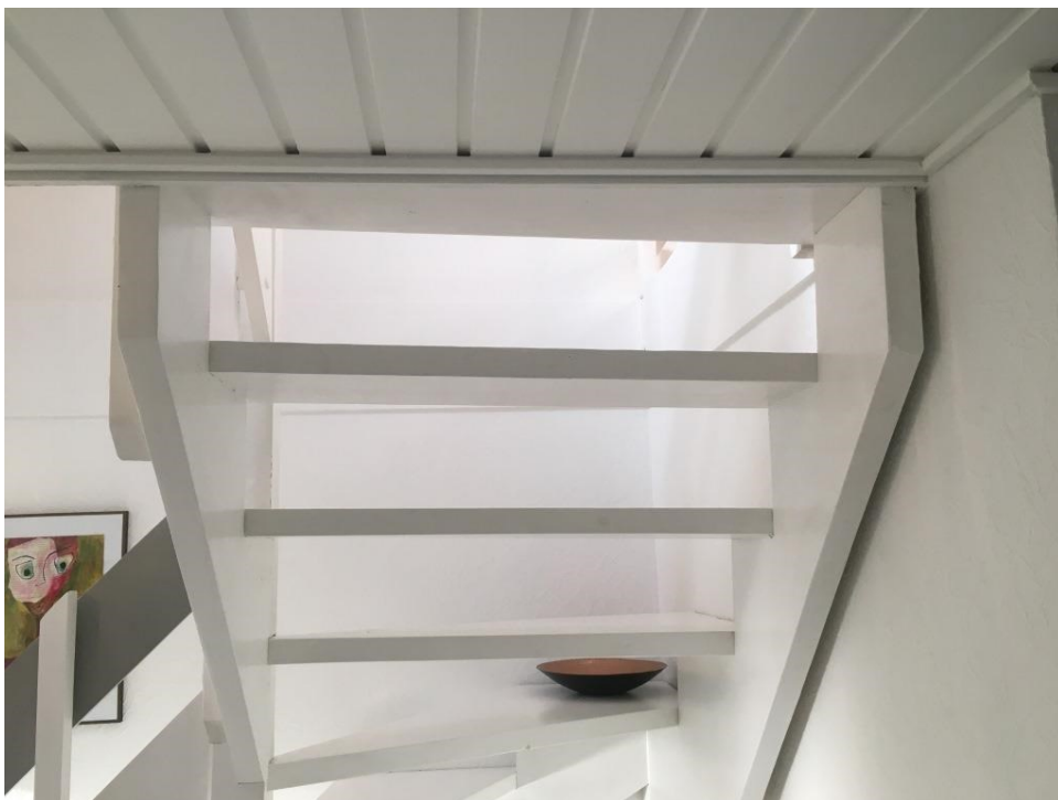
Trappen er udført i træ. De sidste 3-4 trin til 1. sal forekommer relativt skæve, og falder ca. 10-15 mm over gangbredden.
