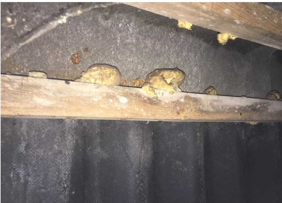
Der kunne i tagrum ses flere steder, hvor der er tætnet med PU-skum i rygning og vandrette samlinger af tagpladerne.
