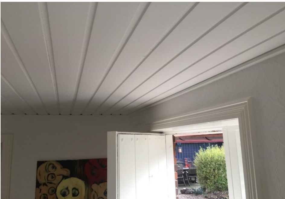
Hoveddøren/ entredøren mod gårdsplads er en massiv yderdør, som lukker ind i entre. Dette medfører, at yderdøren ikke kan afmonteres, da lysning over døren forekommer for lav.
