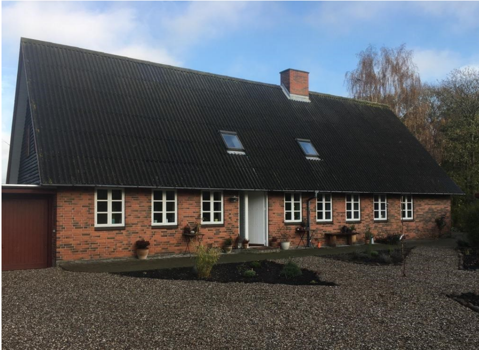
Ejendommen set fra gårdside
