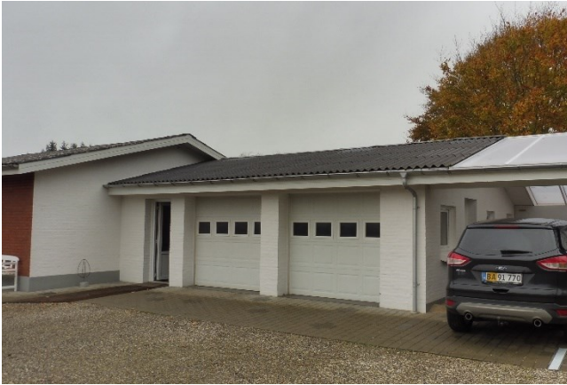
Foto 1 Facade mod syd.
