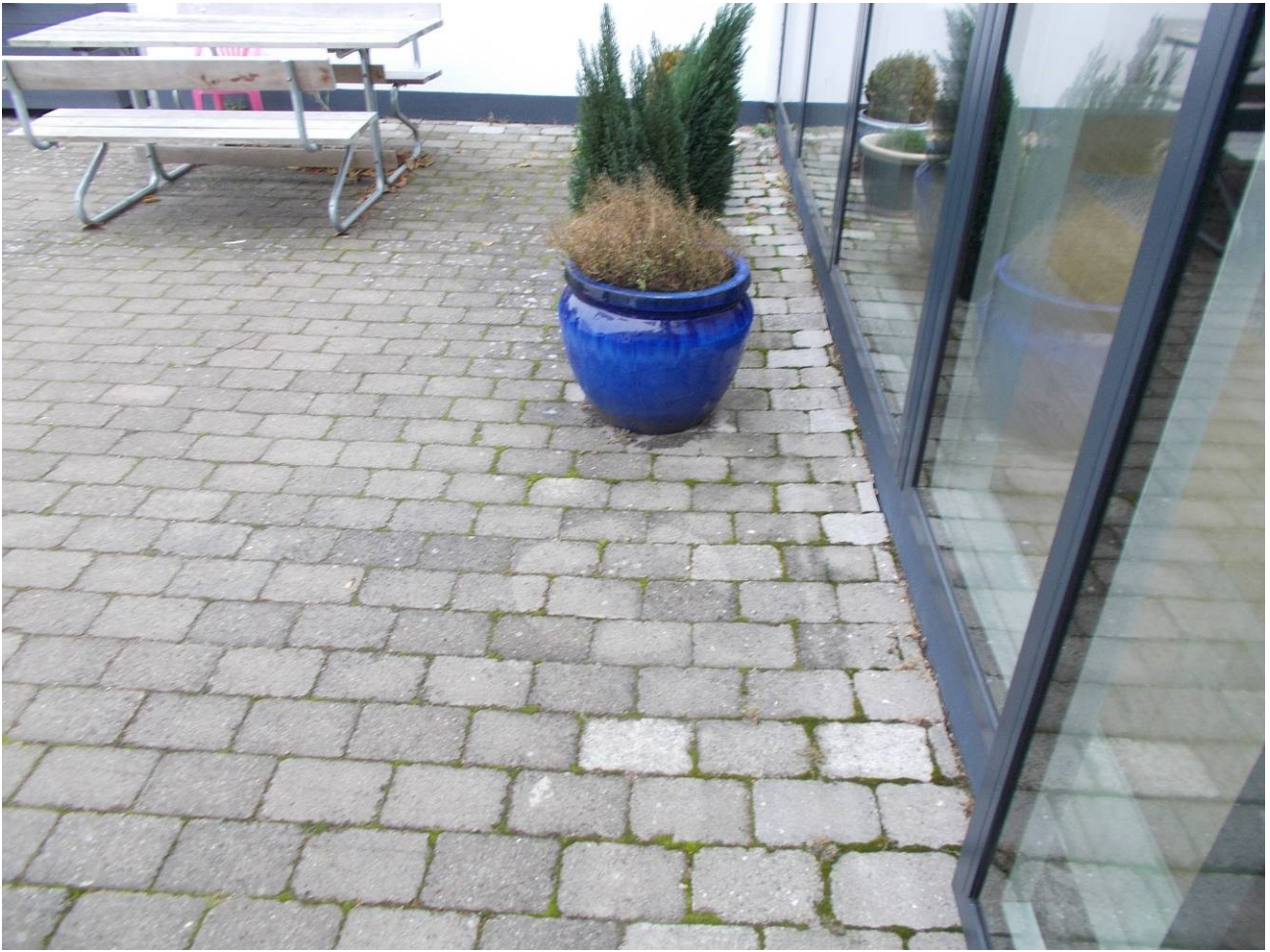
Terræn over sydvæg i FYRRUM (lunken).
