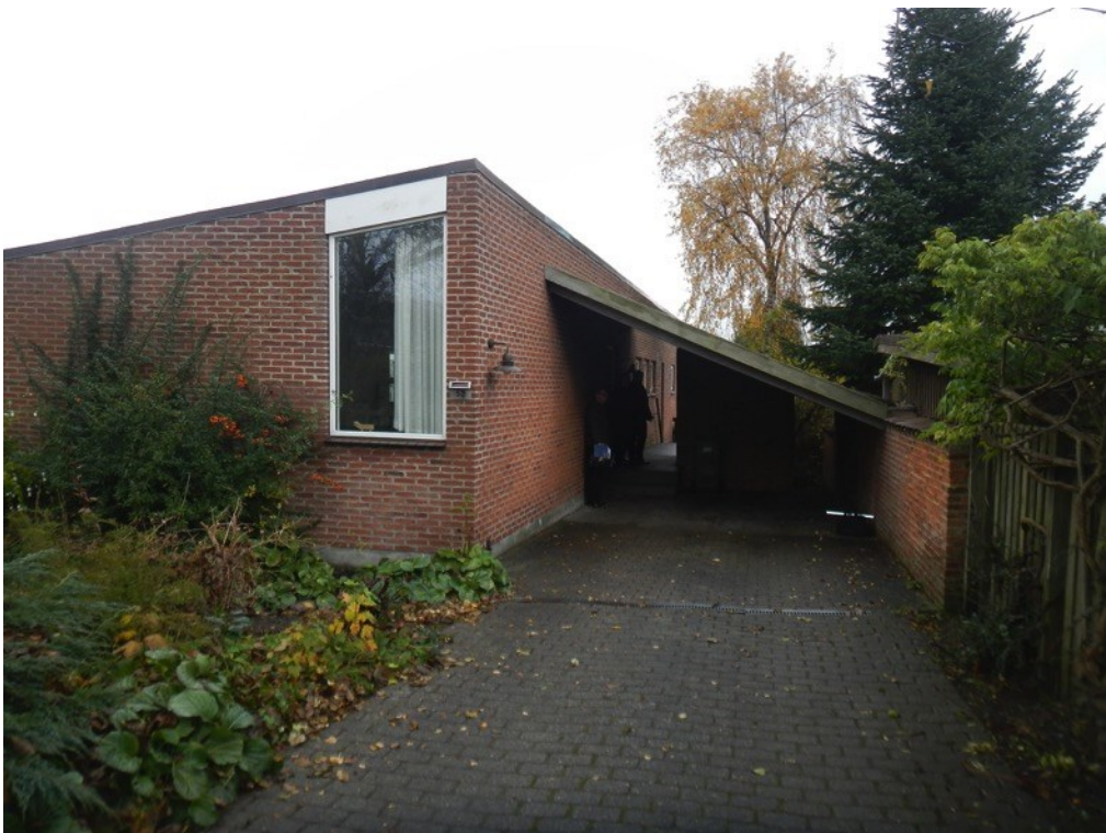
Foto nr. 2 Bygning A (bolig tv) og bygning B (carport th), set fra syd
