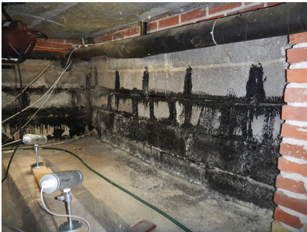
Foto nr. 5 Fundamentet under sydgavlen, set fra krybekælderen. Konstruktionen er helt tør
