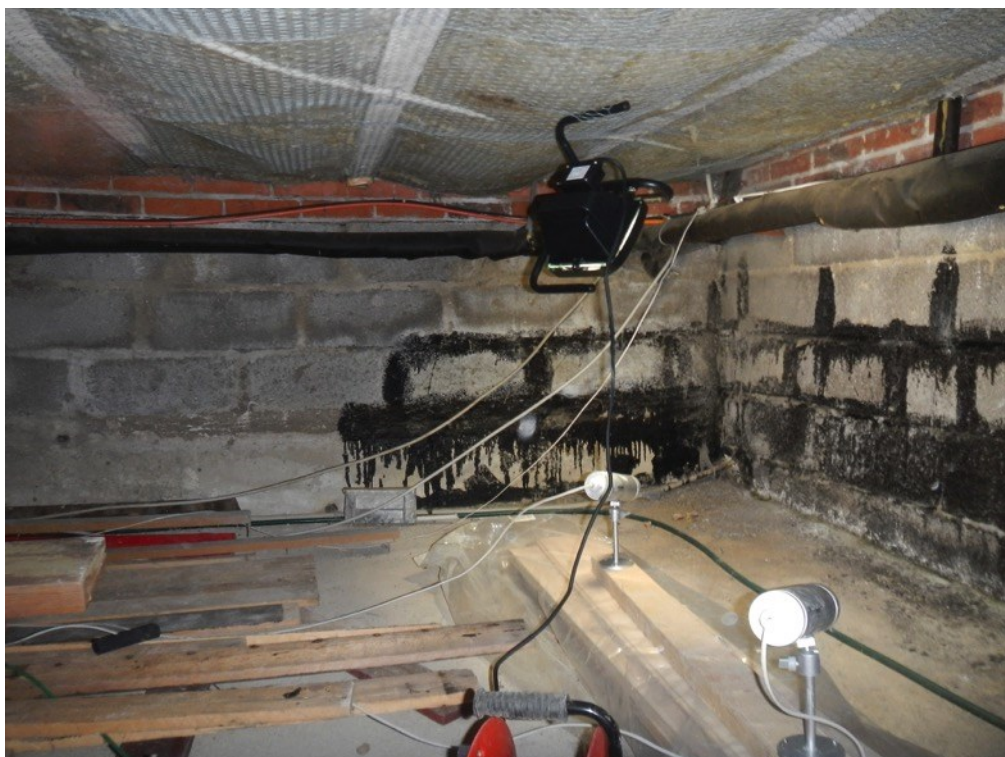
Foto nr. 6 Hushjørne mod sydøst, set fra krybekælderen. Konstruktionen er helt tør
