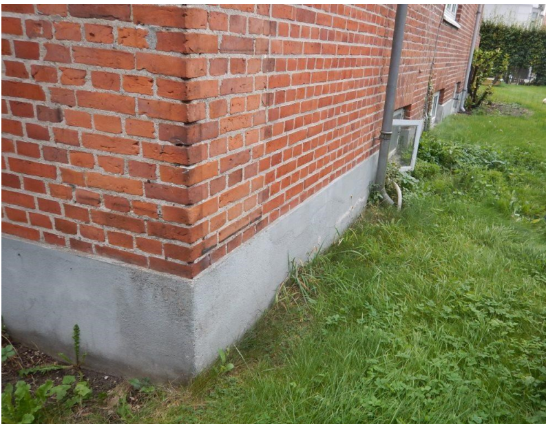
Side af bygningen, hvor slange fra grundvandspumpe kommer ud ad kældervindue.
