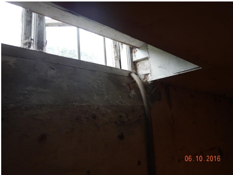
Slange fra grundvandspumpe, som føres ud gennem kældervindue.
