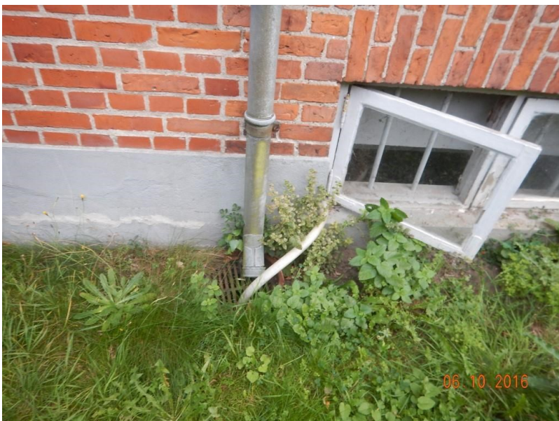
Kældervinduet, hvor slange fra grundvandspumpen føres ud og videre til tagnedløbsbrønd.
