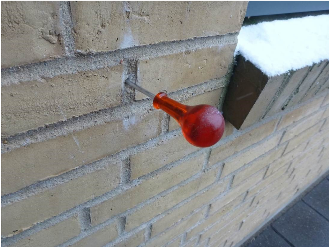
Foto 5 Ud for køkkenet mod øst, kunne der kun konstateres ganske få forvitrede fuger.
