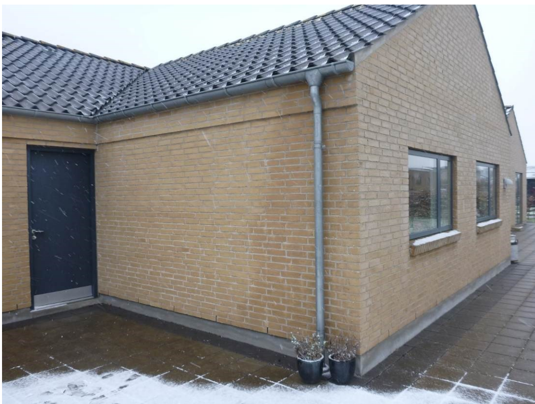
Foto 13 På de nordlige dele af vestgavlne, ses der en farveforskel i murværket, som skyldes et mere opfugtet murværk disse steder.
