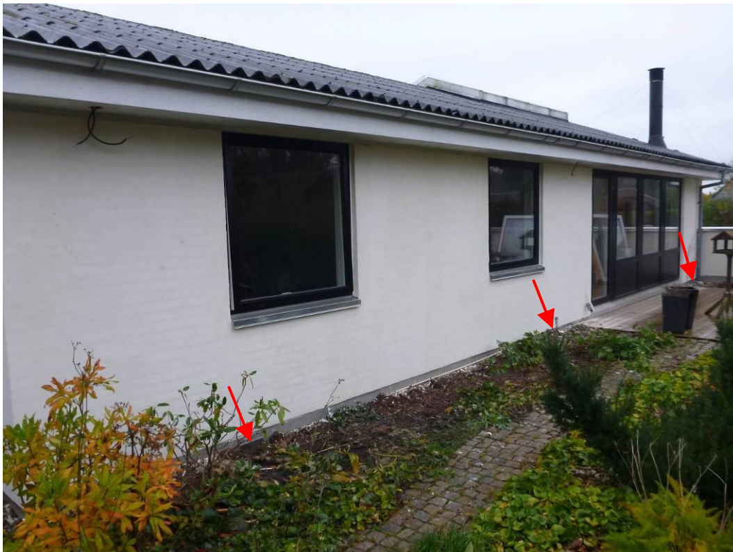
Foto 4 Vestfacaden set fra nordvest – pilene markerer ristenes placering i soklen.
