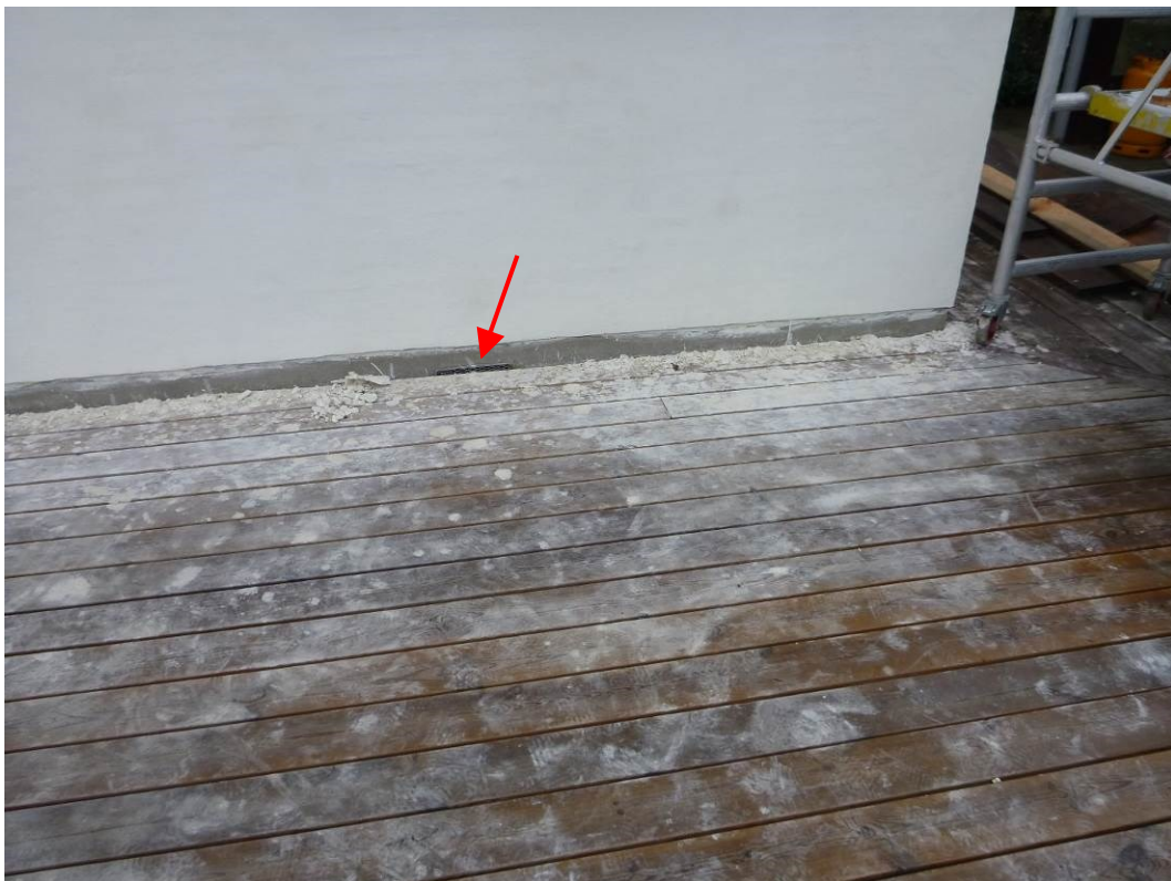
Foto 6 Langs den opbyggede terrasse, mod syd og øst, sidder ristene stort set under bræddernes overside.
