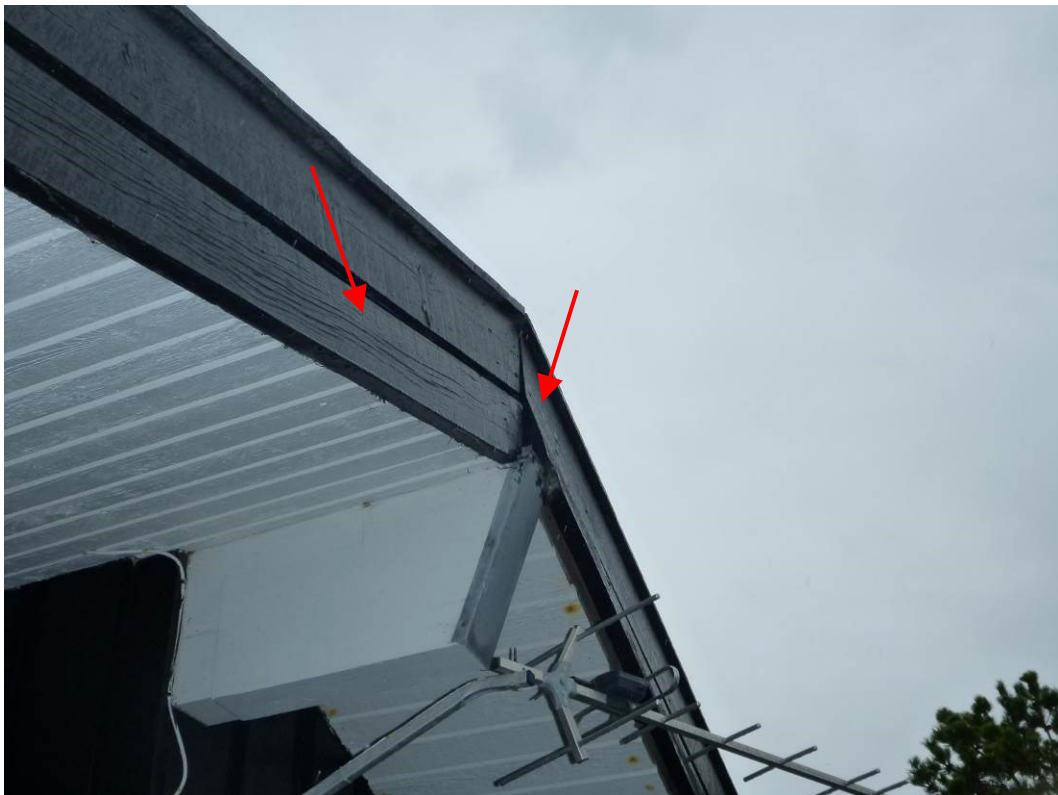
Foto 4 Vindskeder, her mod syd på boligen, fremstår med lidt skævheder og vindrevner.
