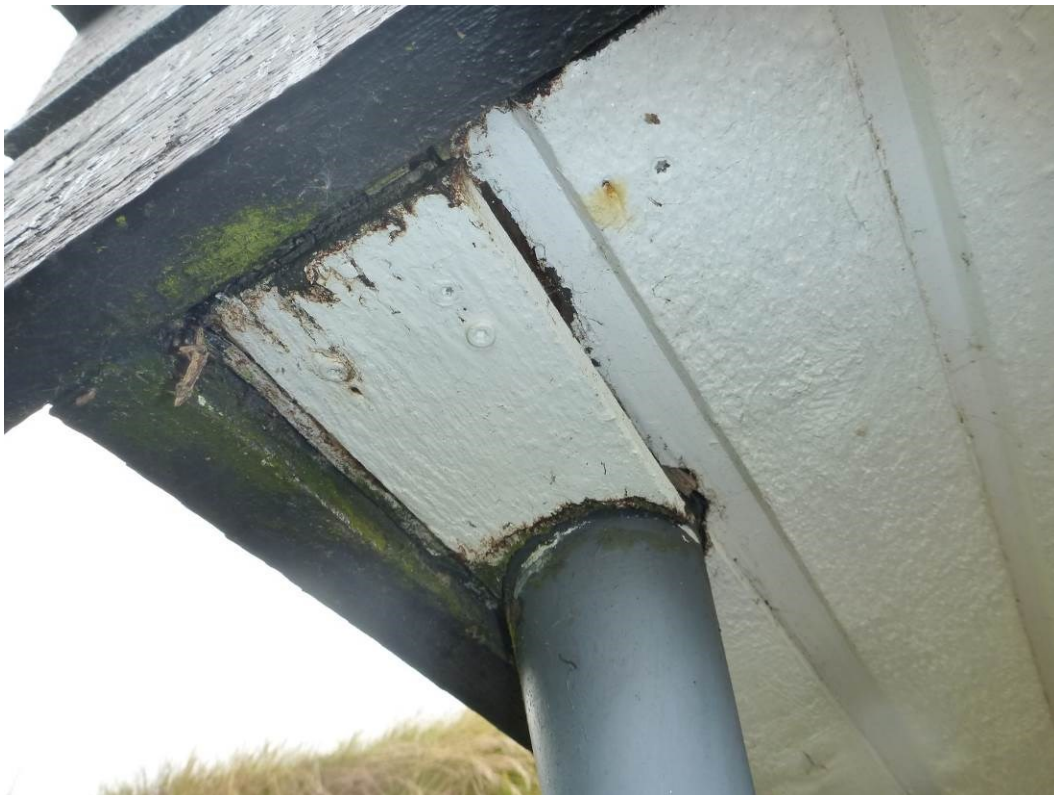
Foto 6 Der ses også løse brædder omkring tagedløbene – her ses der også tydelige tegn på fugtpåvirkninger samt angreb af råd.
