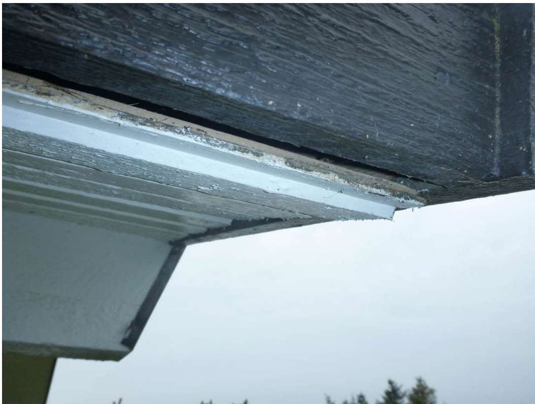
Foto 5 Underbeklædningsbrædderne sidder flere steder løse, dog særligt ved gavlene.
