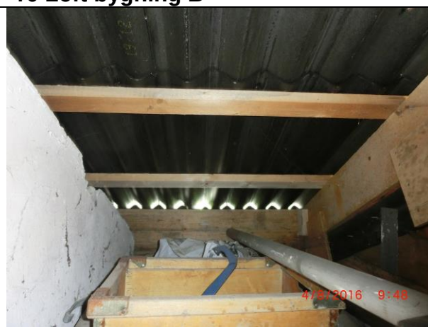
'18. Loft bygning B.
