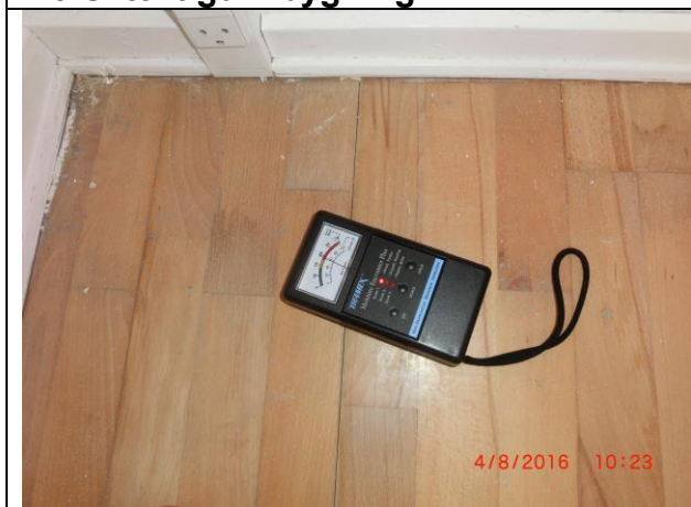
21. Fugtmåling gulv bygn. A
