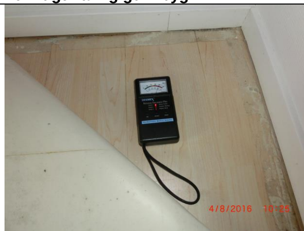
22. Fugtmåling gulv bygning B.
