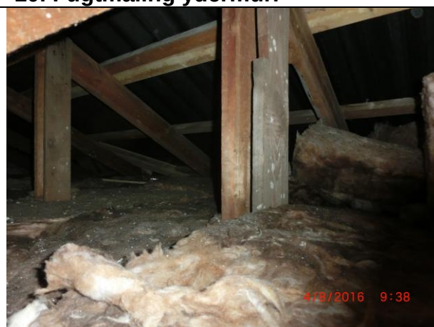
12. Loftrum bygn. A.
