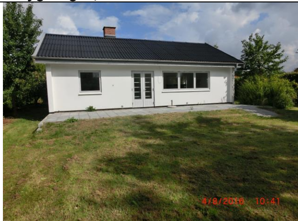
5. Bygning A, sydside.
