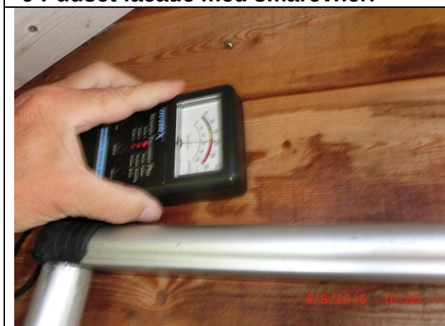
11 Fugtmåling ved sammenbygning A – B.
