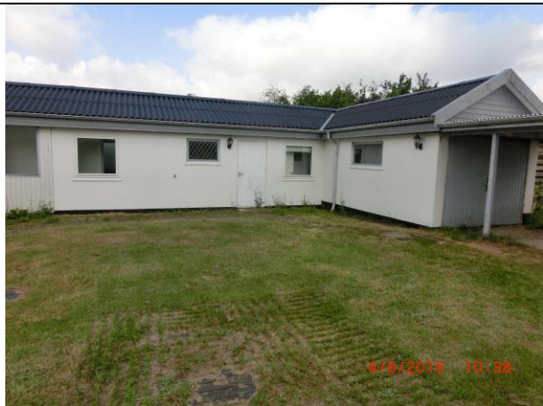
1. Bygning B og Bygning C.
