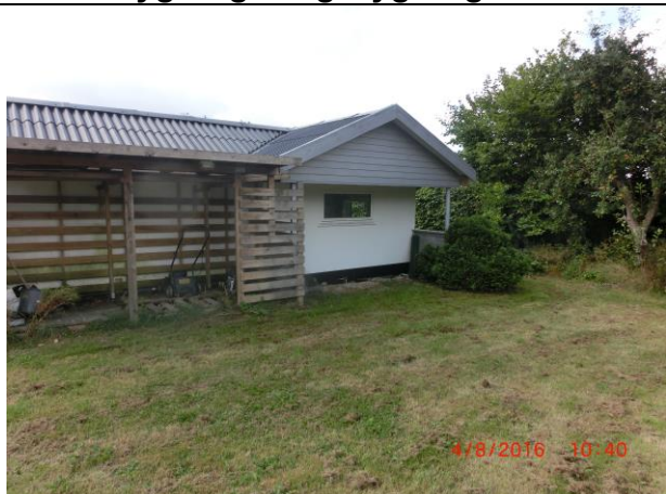
3. Bygning B, Gavlside
