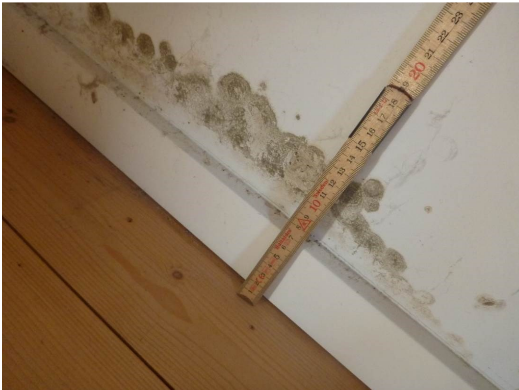
Foto 6 Skjolderne går ca. 10-15 cm. op ad væggen (målt fra gulv).
