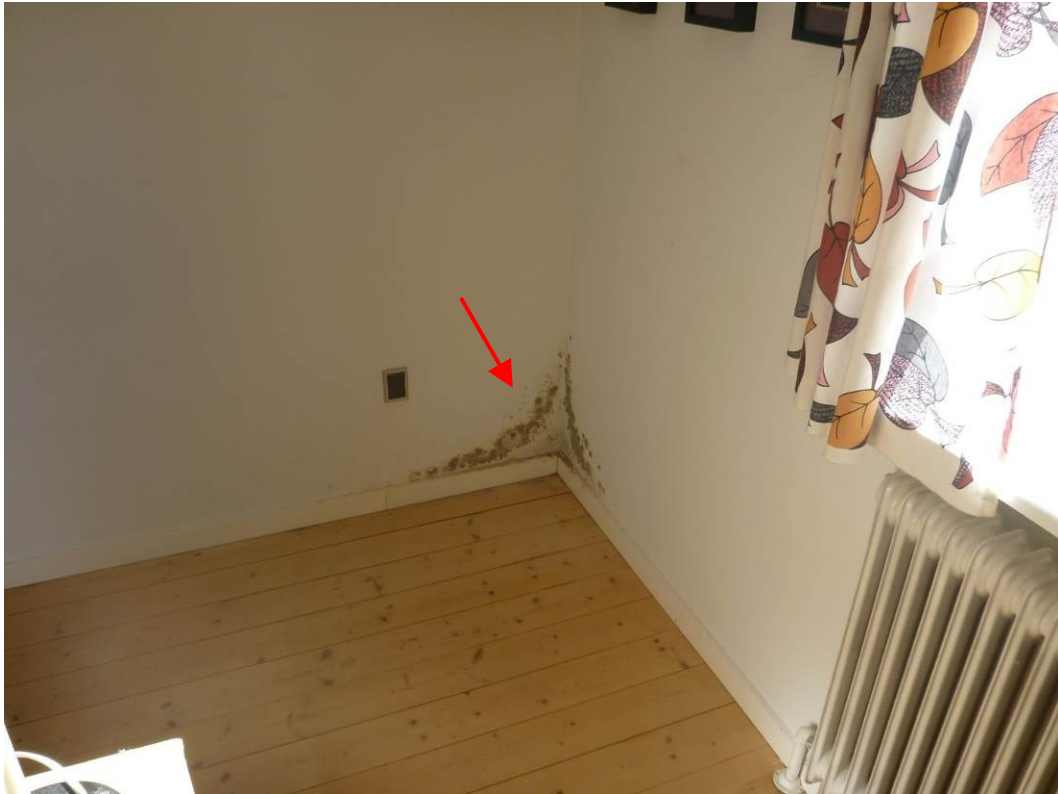
Foto 7 I hjørnet mod nordøst, ses der et "trekantet" område med store fugtaftegn / skimmelvækst.
