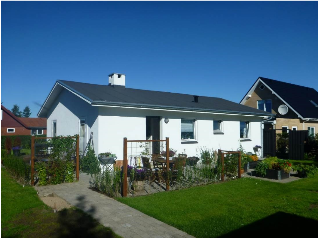
Foto 3 Ejendommen set fra sydøst – der er en mindre kælder under indgangsdøren, og det høje vindue, tættest facaden.
