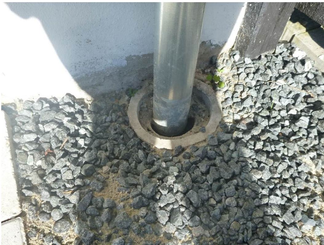
Foto 17 Tagnedløbet mod nordøst ses at være ført korrekt ned i tagnedløbsbrønden.
