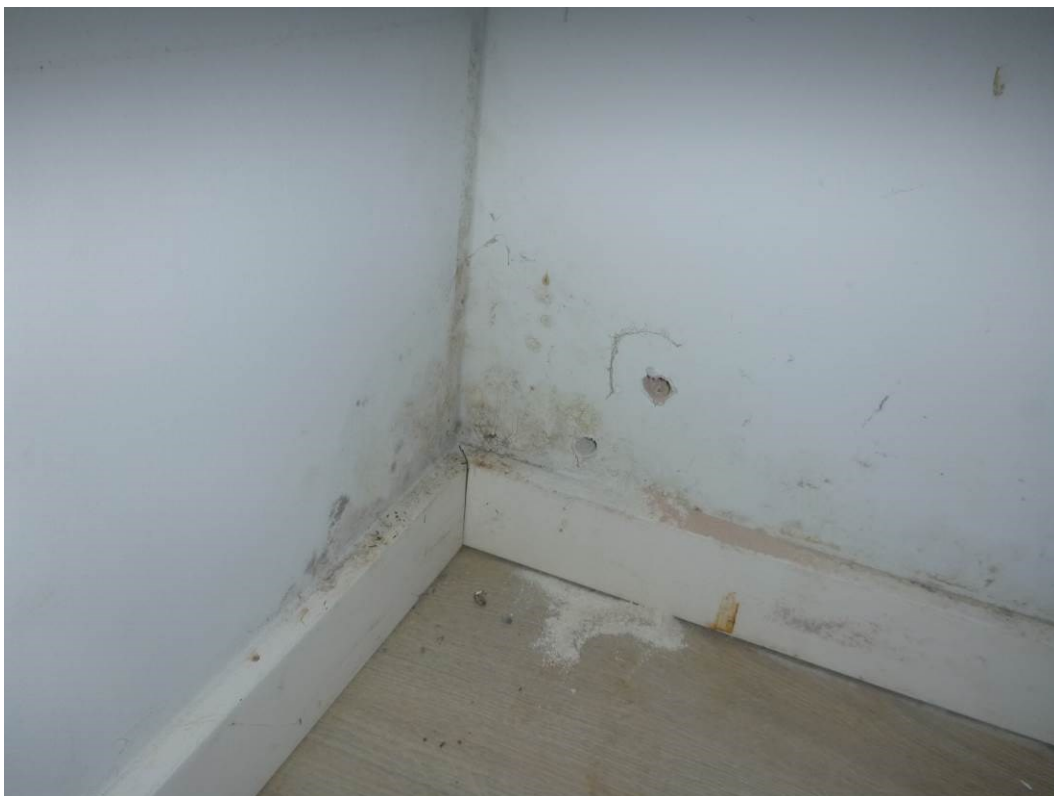
Foto 11 I hjørnet mod nordvest ses affegnene i lidt større grad – hullet er boret af KK's forsikringsselskab.
