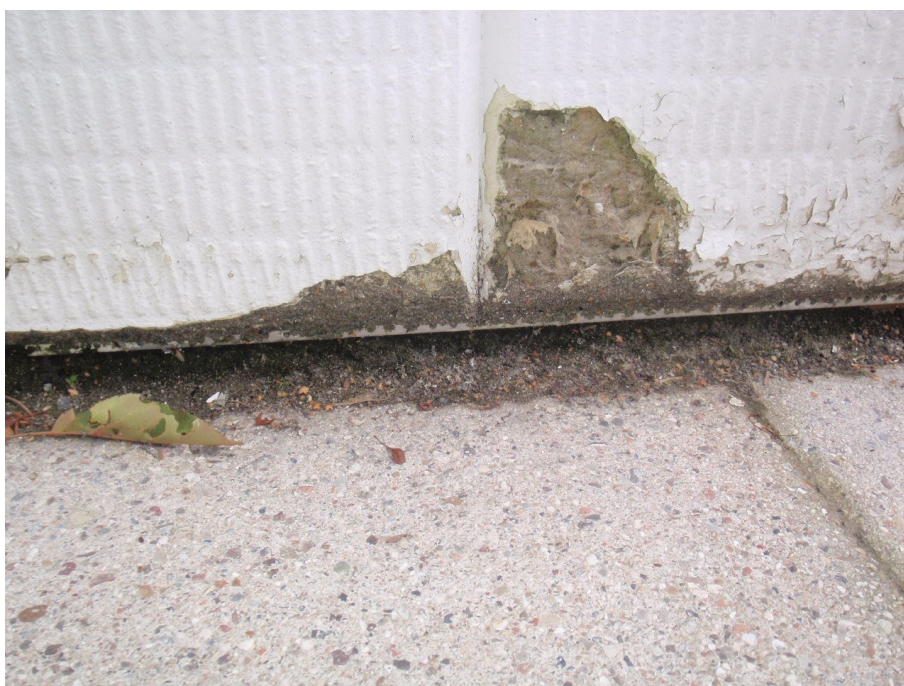
Foto 4 visende nederste r kke batts, skadede
