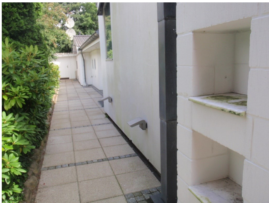
Foto 5 visende vestgavl – tilbygning – pladebeklædning
