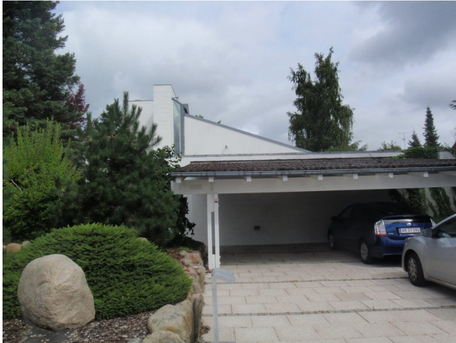
Foto 1 visende huset – carport – set fra vejen, syd
