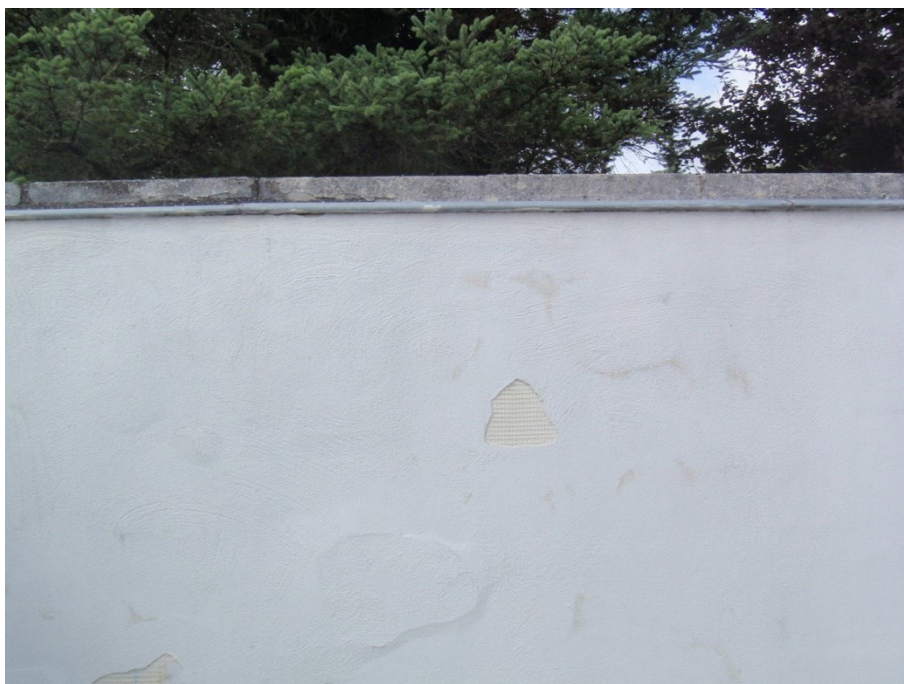
Foto 11 visende skadet puds læmur – vest
