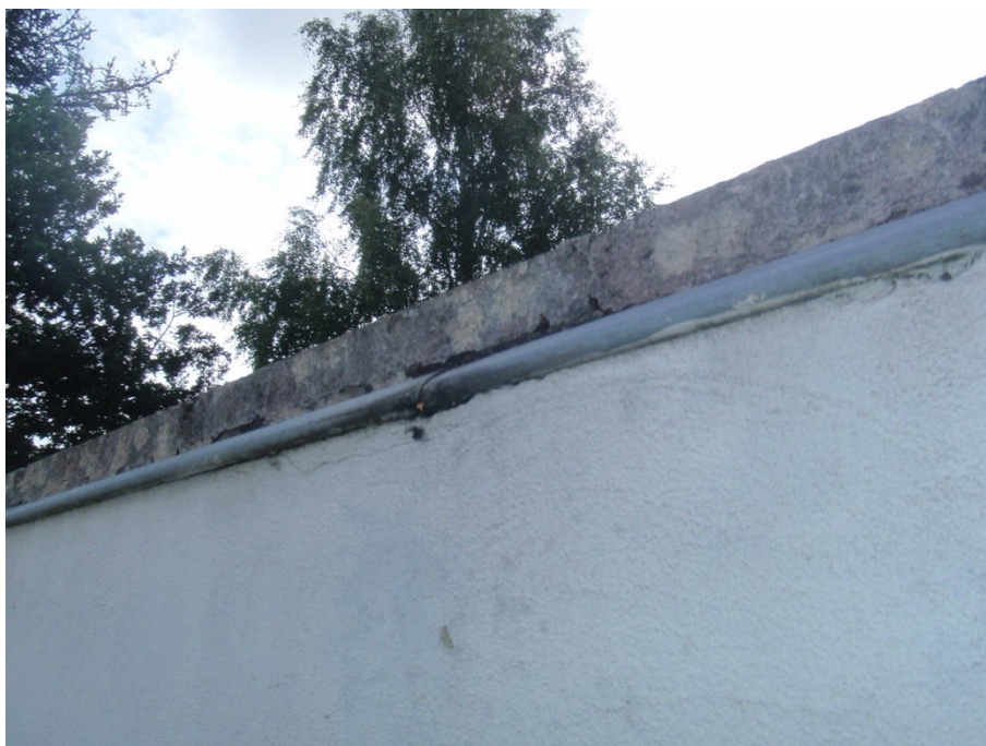
Foto 13 visende afrundet – forkert udført løskant
