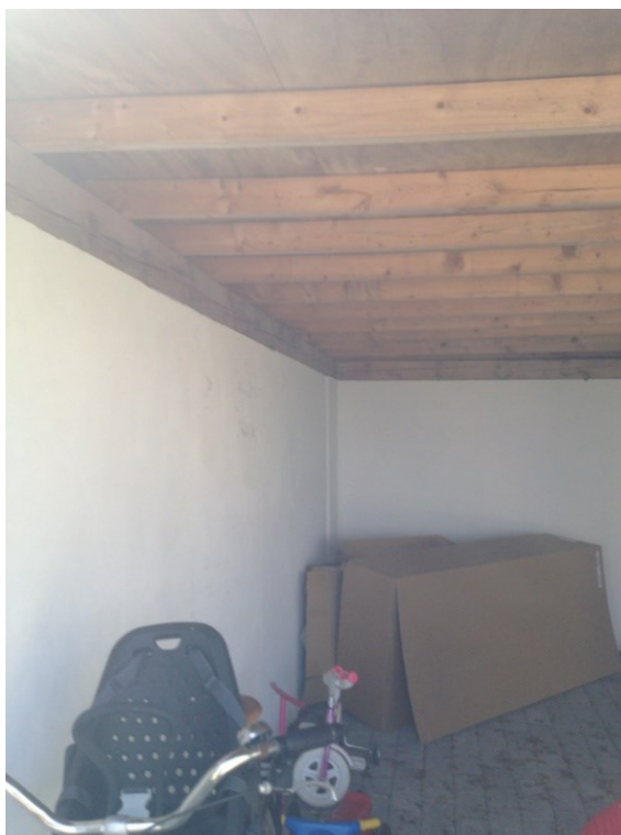
Foto 37 visende bjælkespær – carport
