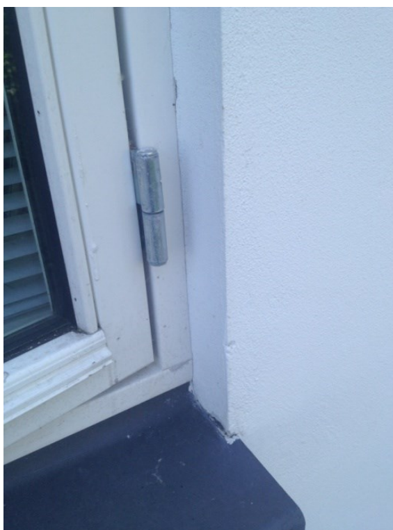
Foto 16 visende pudset ud på/til karmtræ
