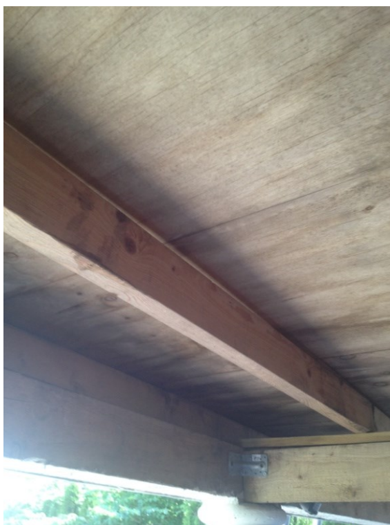
Billede 38 visende luft mellem krydsfinér/spær
