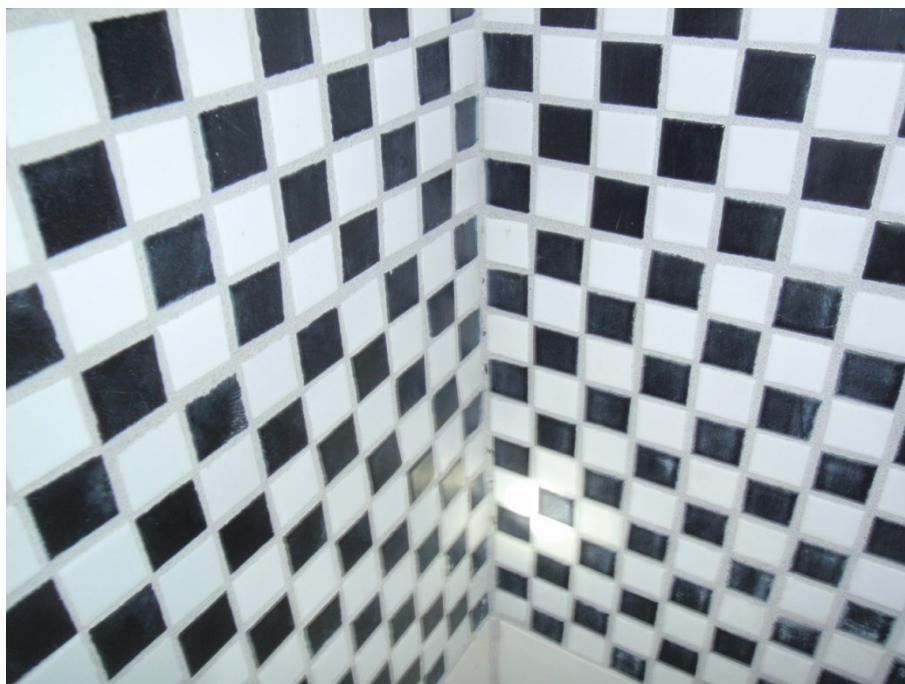
Foto 9 visende hullede fuger i hjørne af nichen
