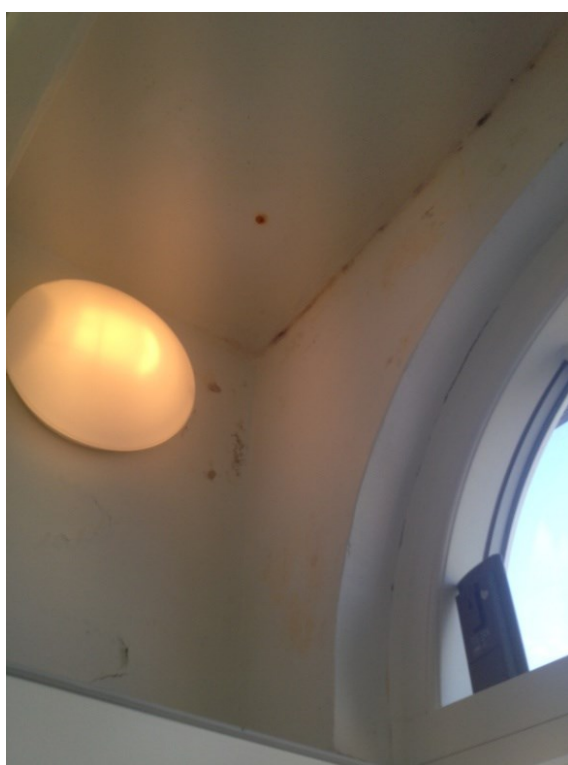
Foto 28 visende fugtskjolder i loft/karnap
