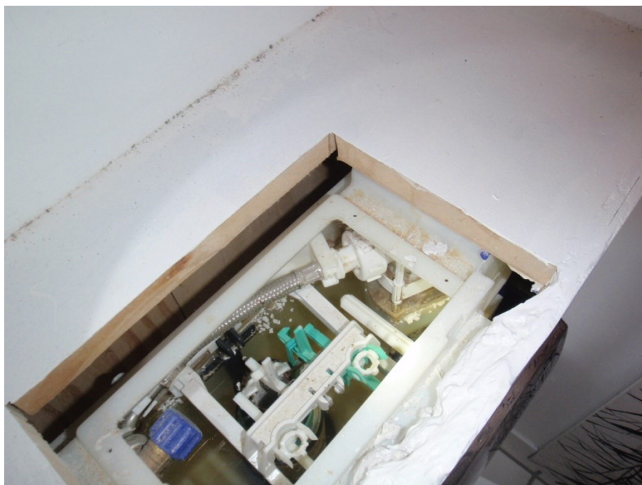
Foto 15 visende kloset forankret til spinkel kasse
