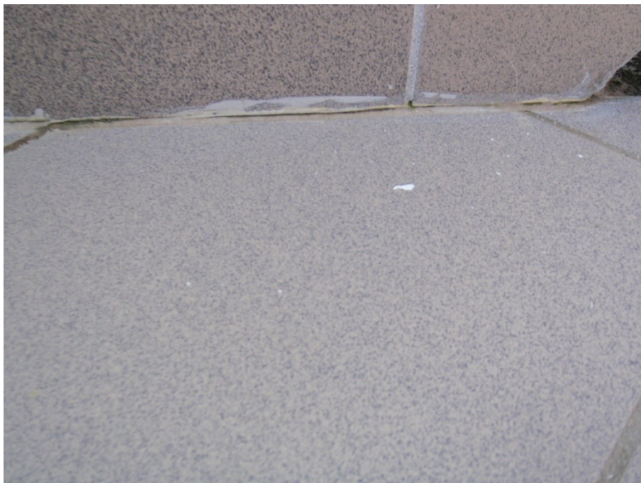
Foto 23 visende slip ved fuger mod sokkelfliser
