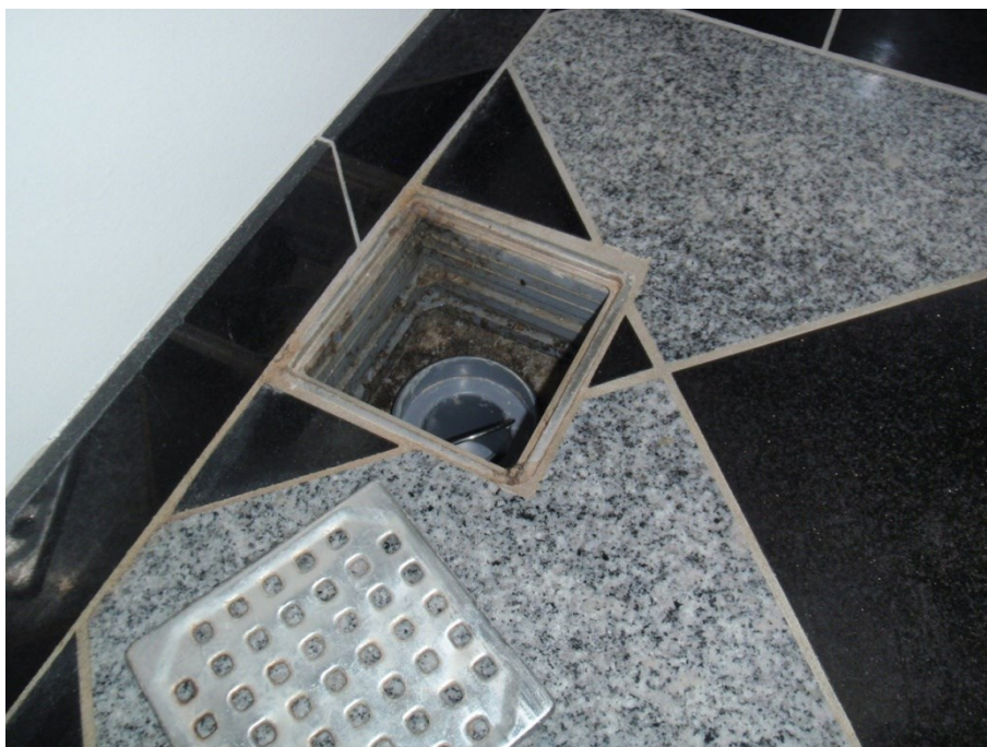
Foto 11 visende forhøjelsesringe i gulvafløb
