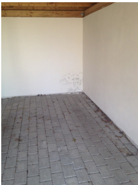
Foto 34 visende pudsafskalning i carport
