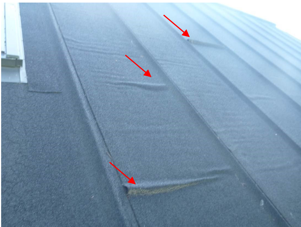
Foto 3 Synlige folder og generelt ujævnheder i overpappen på den vestlige tagflade.
