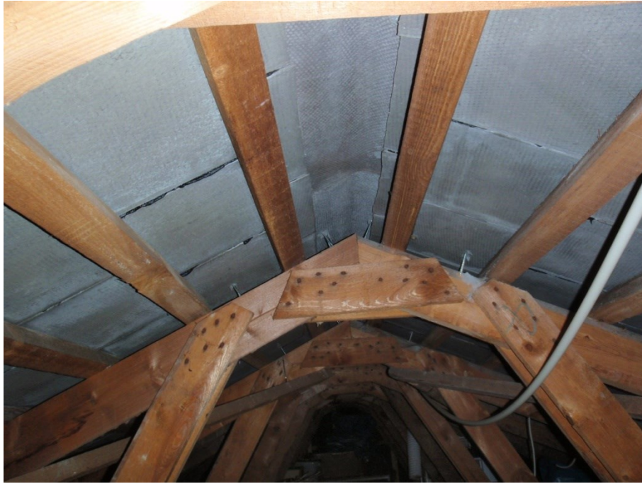
Foto 7 visende gl. eternittag, nye afstandslister m.m. fastskruet til spær
