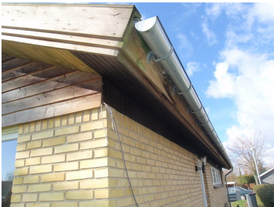
Foto 6 visende opfugtet træværk
