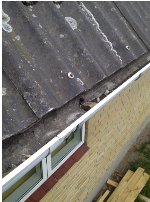
Billede 3 – Murstensskaller i tagrende – vest
