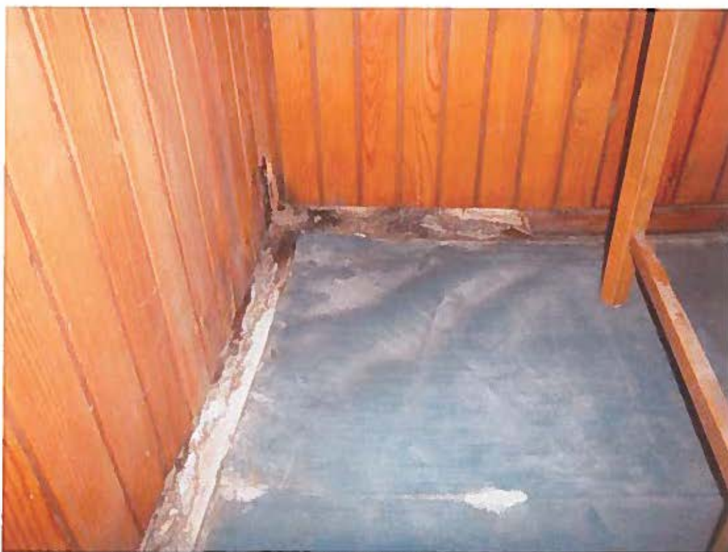
Foto nr. 4 Oplugtning i træbeklædningen i glidesalen
