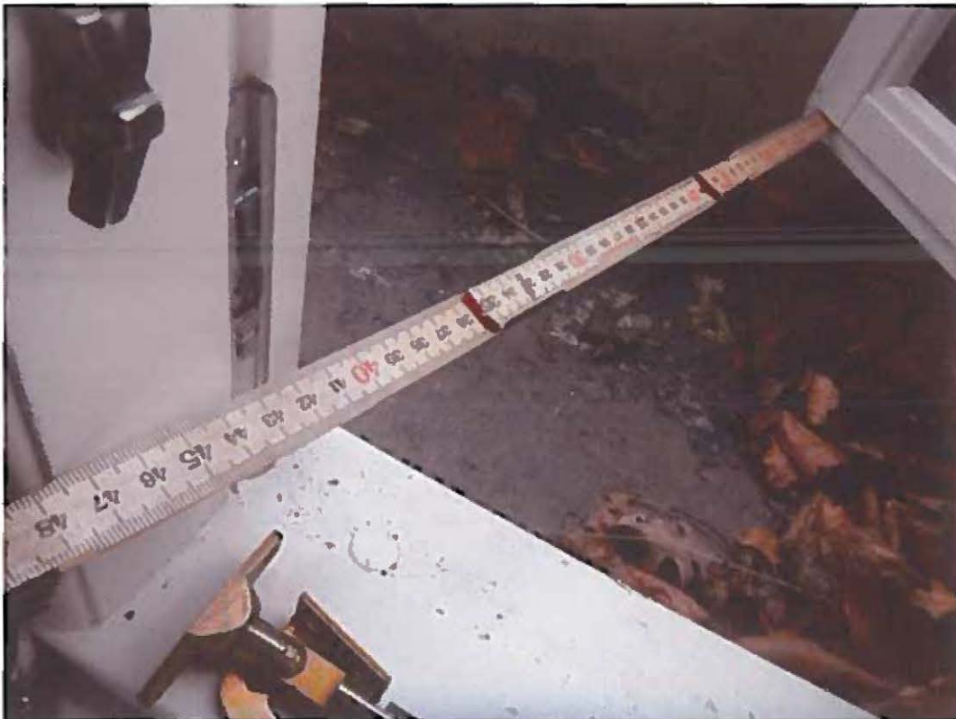
Foto nr. 11 Fri åbningsbredde i kældervindue 42 cm
