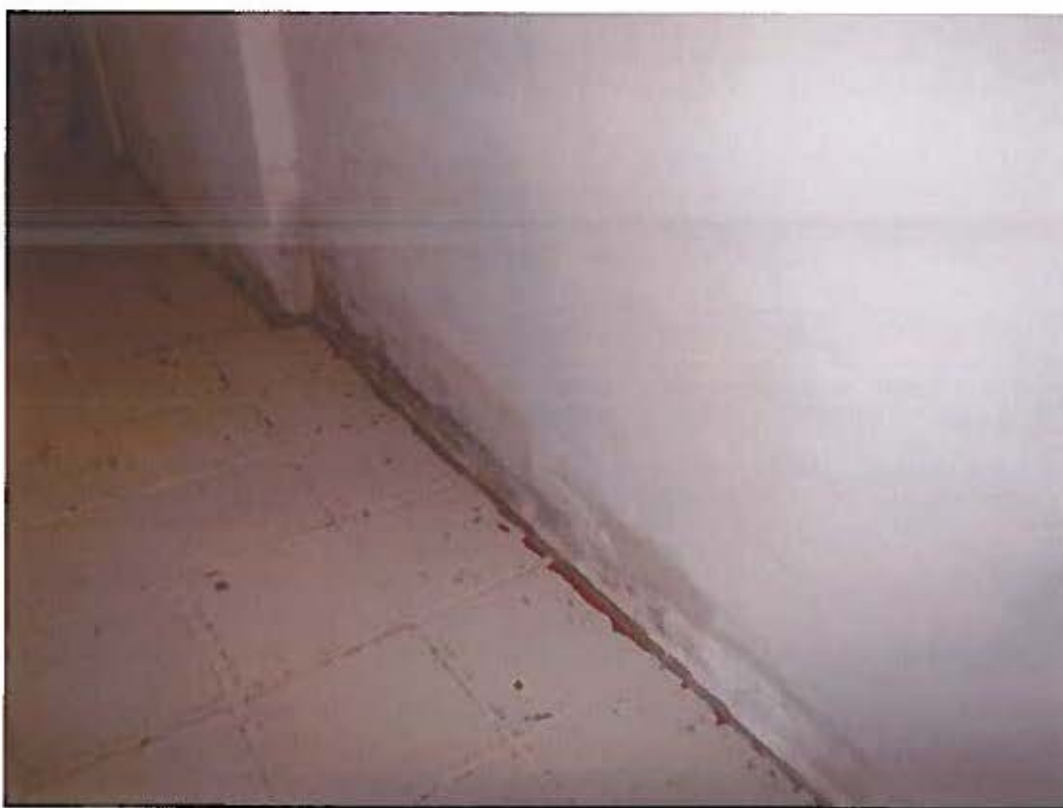
Foto nr. 3 Opstigende grundfugt i hovedskillerummet i kældergangen
