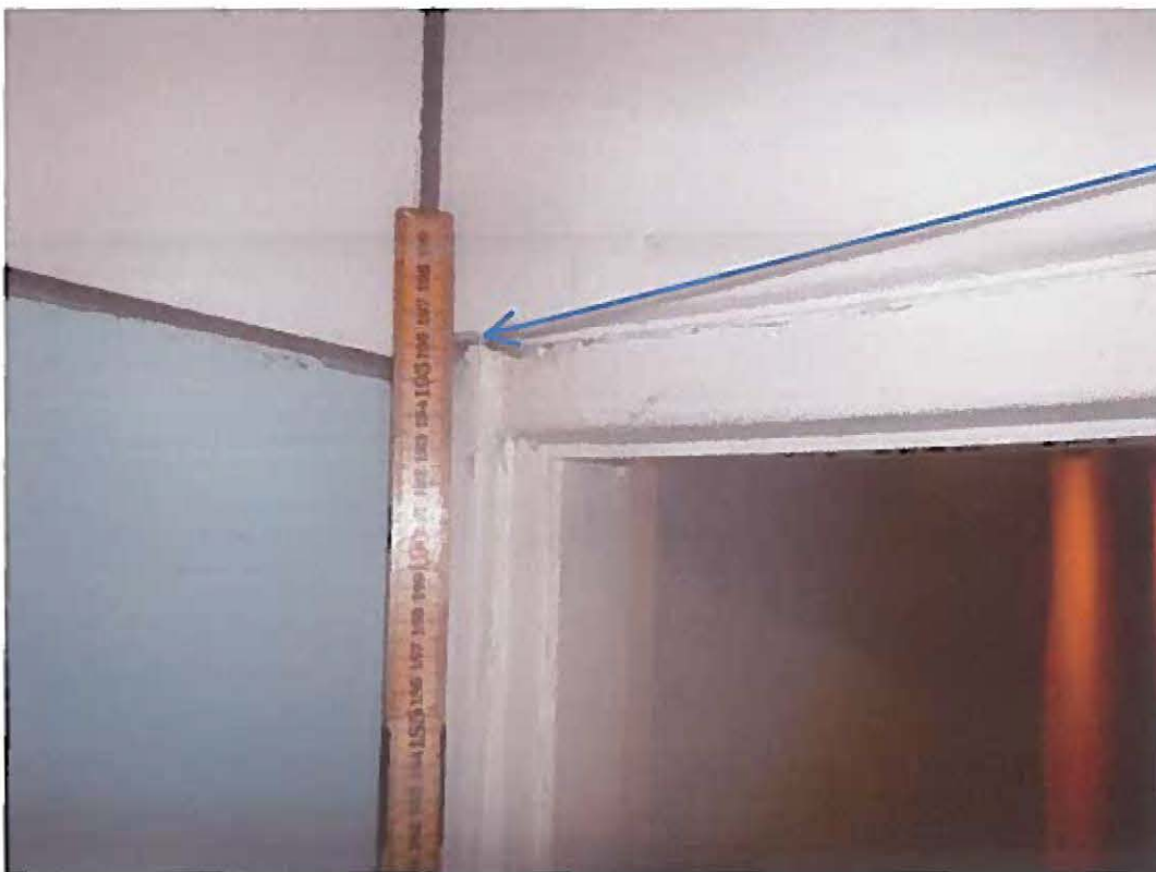
Foto nr. 7 Lofthøjde i kældergangen ca. 196 cm før træloftet blev nedtaget
