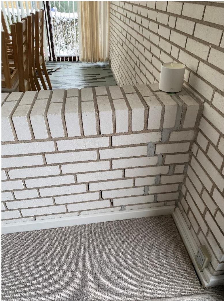
Ad 1 – halvmur med revner og sætning
