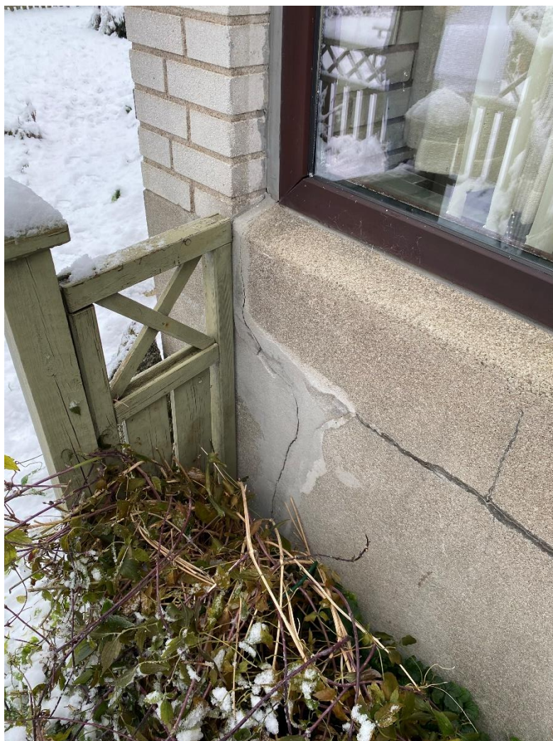
Ad 1 – murværk og sokkel i hjørne mod nordvest
