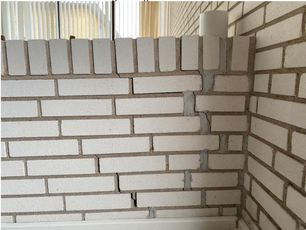
Ad 1 – halvmur med revner og sætning
